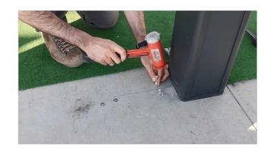
Étape 4 - Serrage des vis de fixation
